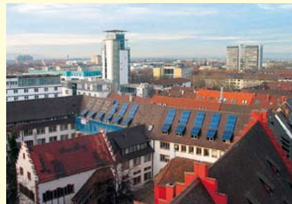
시청 지붕위의 태양광 발전시설
